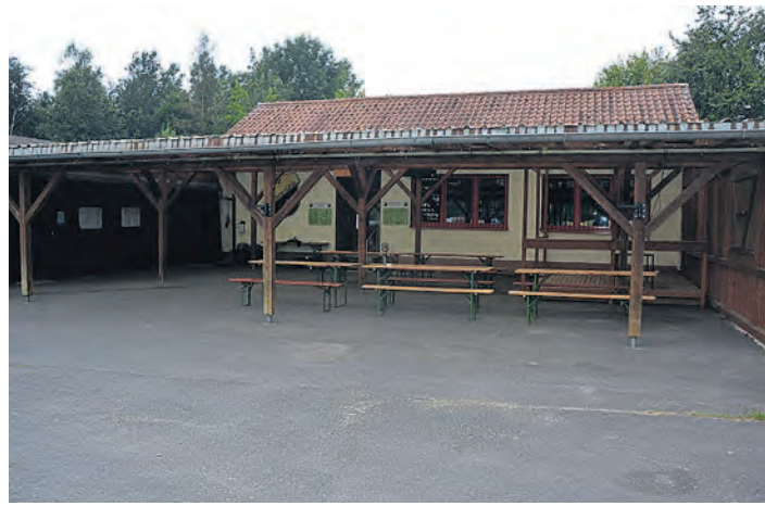
Der Eingangsbereich zum neuen Dorfmittelpunkt und SV-Sportheim wird barrierefrei ausgebaut, um damit auch Menschen mit Behinderung die Möglichkeit zu geben, sich in größeren Rahmen zu treffen. Mit einem Kostenaufwand von 300000 Euro wird das Sportheim ausgebaut und ertüchtigt. (jr) Bilder: jr
