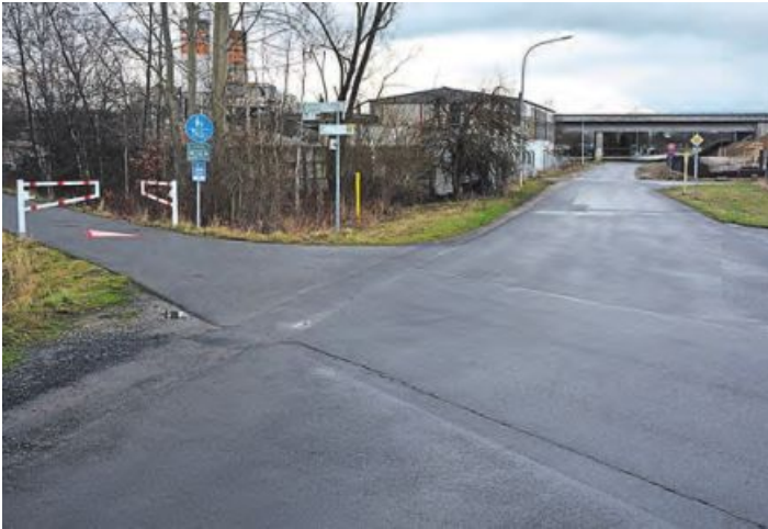
Ab hier, links die Einfahrt zum Fuß- und Radweg zum Kreislehrgarten und in die Innenstadt, beginnen die Ausbauarbeiten der Carl-Zeiss-Straße in Richtung Staatsstraße 2169. (jr) Bild: jr
