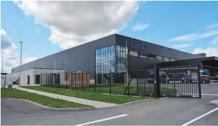
Die neue mächtige Otto Schott-Logistikhalle in Mitterteich. (jr) Bild: jr
